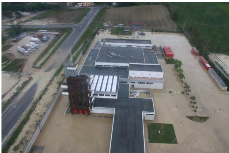
Figura 97: Senigallia - Sede distaccamento Vigili del Fuoco.
