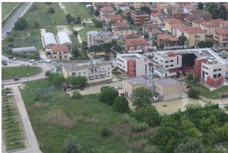
Figura 91: Senigallia - Via G. Bruno - Centrale Telecom.
