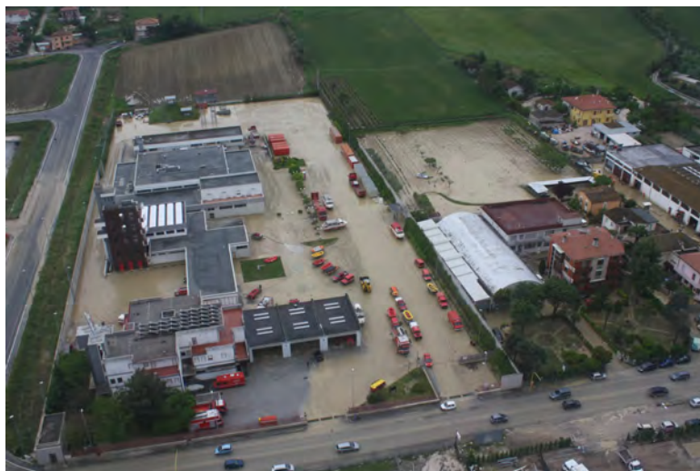
Figura 98: Senigallia - Sede distaccamento Vigili del Fuoco.
